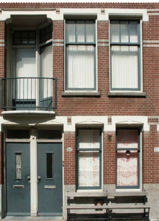
De Sleephellingstraat voor de renovatie.
