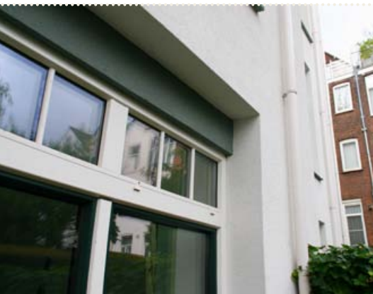
Achterzijde na renovatie met isolatie aan de buitenkant.
